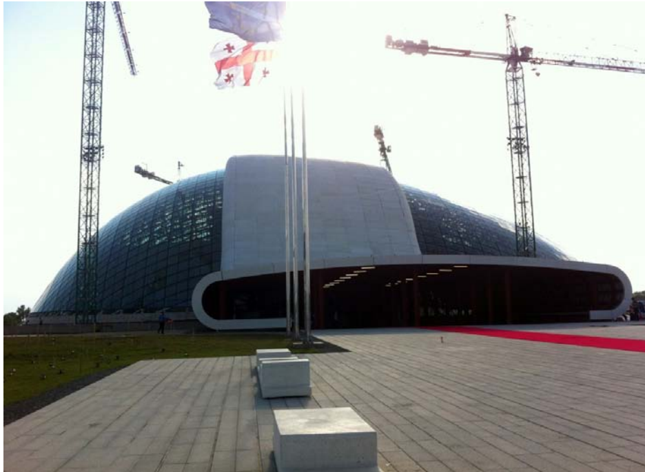
Das gerade eröffnete neue Parlamentsgebäude in Kutaissi, gleichfalls entworfen von spanischen Büro CMD Ingenieros Foto: CMD Ingenieros, Granada
