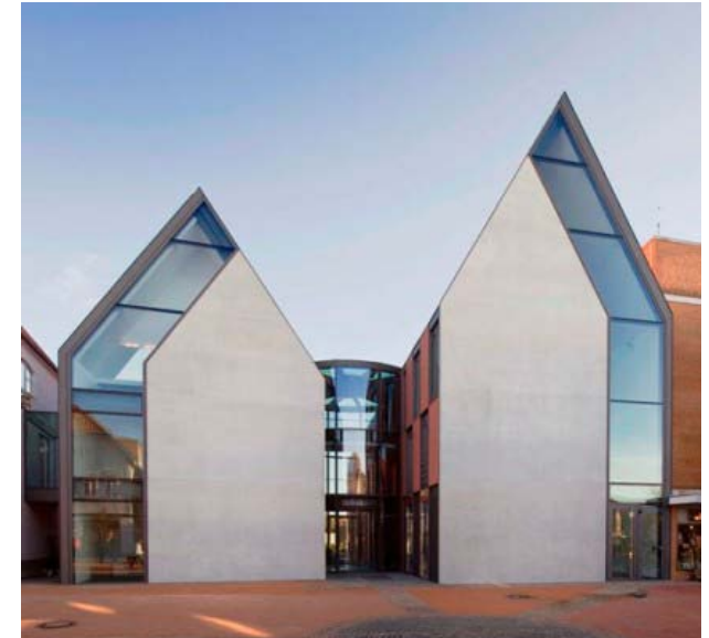
Bankgebäude in Gifhorn
