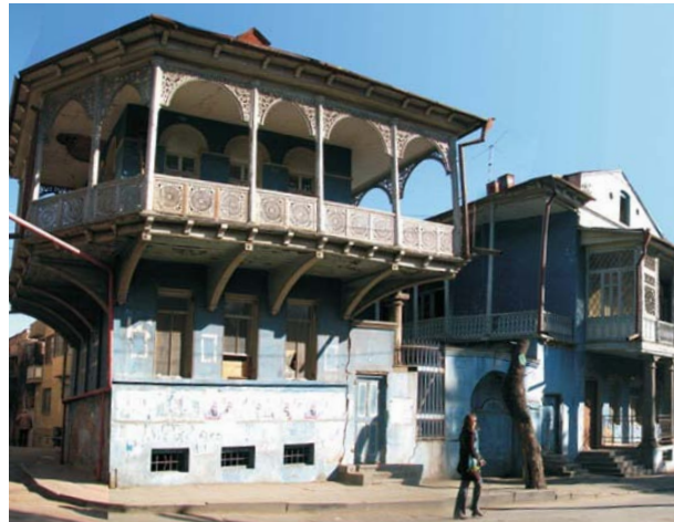
Haus Gudiasvili Platz 2 Zustand vor der Kahlschlagsanierung ...
