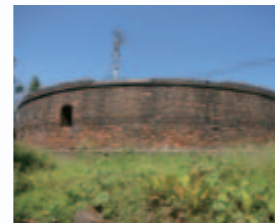
Maruyama Tank 丸山タンク
