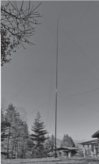
1.8MHz用パッチカル・アンテナ(A50BOC、A5B)
