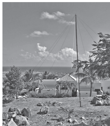
TO9Wの受信用SAL20アンテナ 8方向の指向性切り替えが可能
